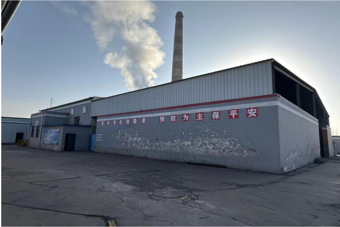
全封闭锅炉房
