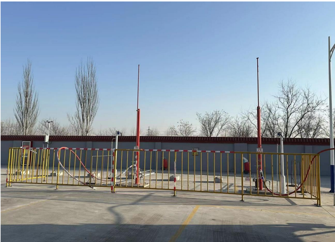
燃气车辆槽车位
